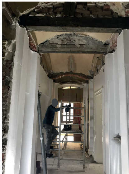
Flurbereich nach der Freilegung
