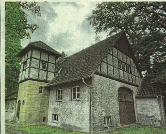
Das alte Turmhaus von 1964 steht unter Denkmalschutz. Im kleinen Vorbau neben dem Deelentor findet sich der mutmaßlich älteste Torbogen in Steinhagen von 1610.
