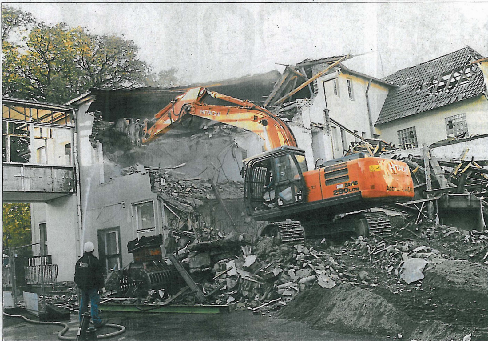
Eine große Ecke vom Gebäude war gestern Nachmittag schon weg. Mit einem scherenartigen Greifarm riss der Bagger die Innenwände schein-
